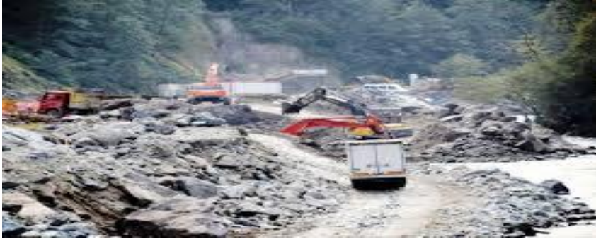
Resim3: HES Projesi İnşaat Aşaması Sırasında Yol Açma Çalışmalarından Bir Görüntü
